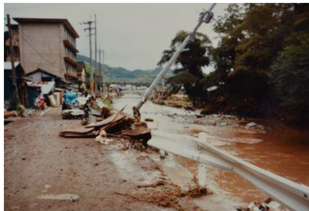
茂木小学校前付近の旧県道
