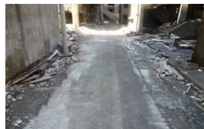
図11 現状の管理用道路
