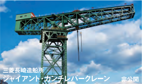
三菱長崎造船所 ジャイアント・カンチレバークレーン
