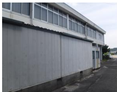
【屋内運動場外壁改修工事】
