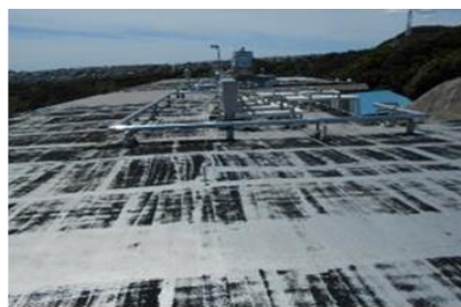
【校舎屋上防水改修工事】
