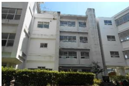
【校舎外壁改修工事】
