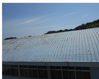
【屋内運動場屋根改修工事】
