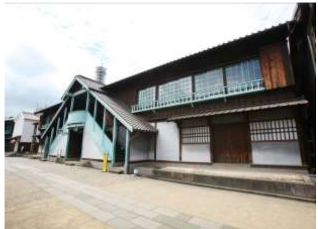
—カピタン部屋外観—
