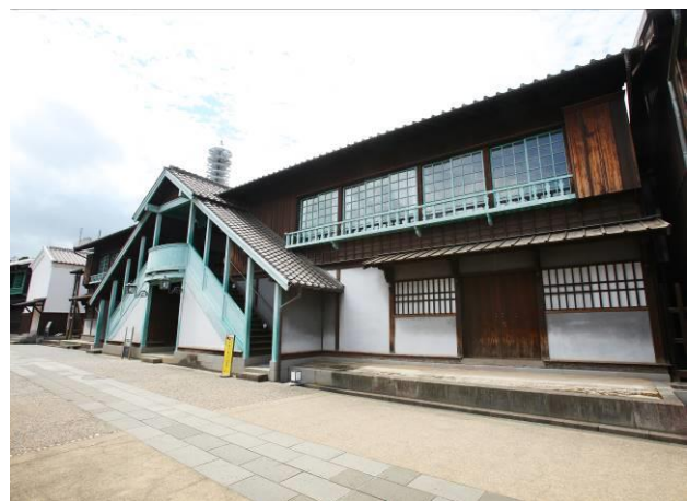
—カピタン部屋外観—
