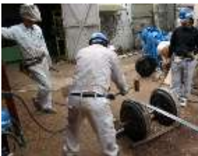
鉄板を車輪に溶接する様子
