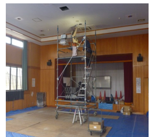
(取替工事の様子)
