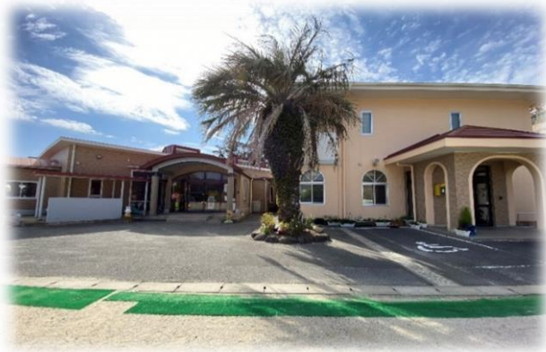
園庭から見た園舎
