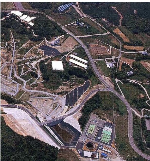
三京クリーンランド埋立処分場
