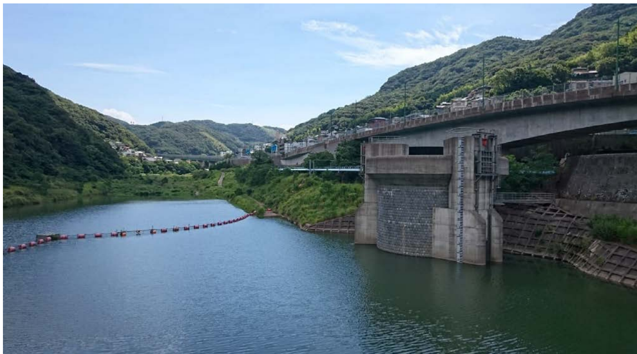
本河内低部ダム取水塔
