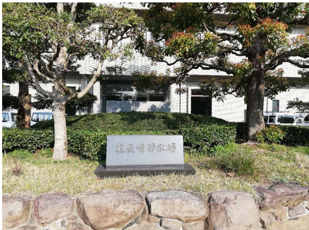
東長崎浄水場
