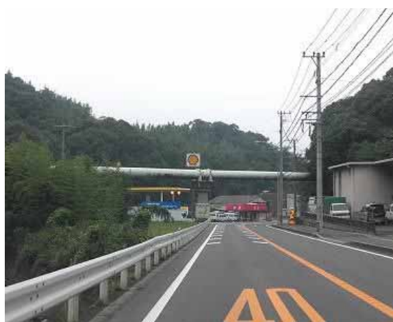
【多以良町にある水管橋（導水管）】
