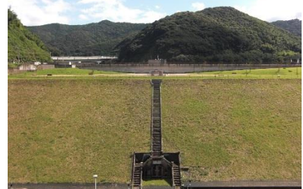
本河内高部ダム堰堤中央階段
