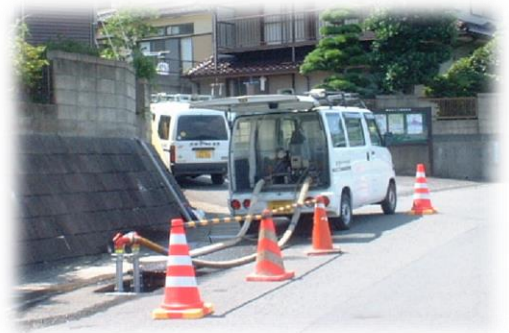
漏水調査をしている様子
