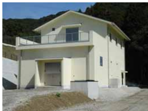
【小浦ポンプ場】
