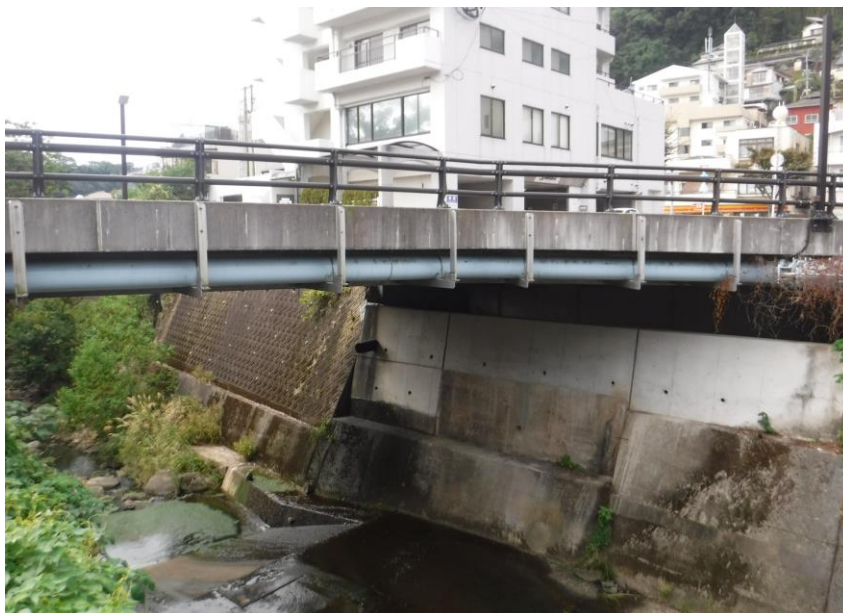
片淵橋 (片淵 4 丁目) 平成 26 年更新 全長 16m φ600 (導水管)
