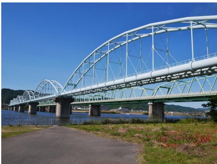
六十谷水管橋 1975（昭和50）年建設 全長 546m（9 径間） φ900×2 本（送水管）
