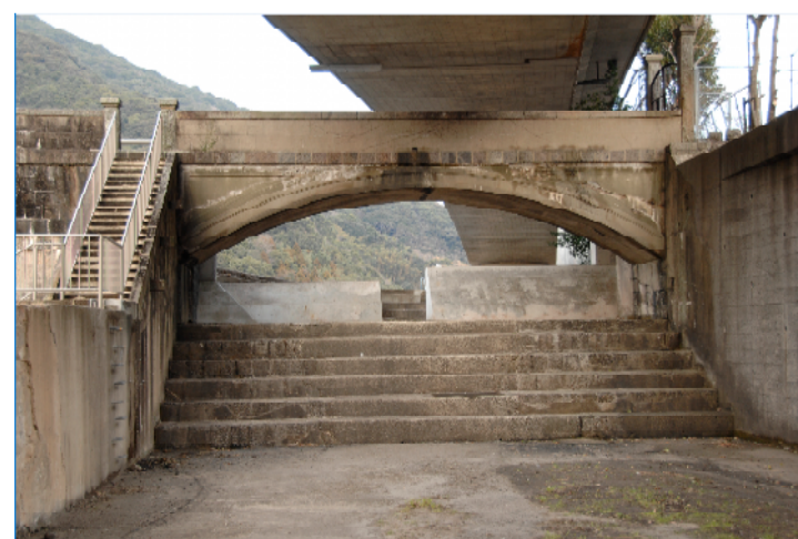
⑪【放水路橋】
