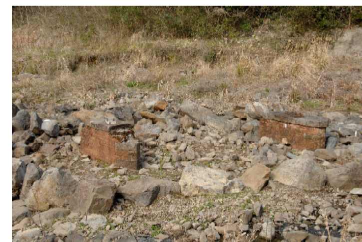
⑦【旧鉄管橋梁橋脚】
