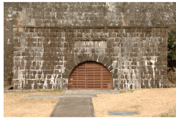
⑨【送水用隧道坑門】
