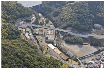
小ヶ倉浄水場
