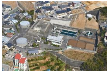
道ノ尾浄水場
