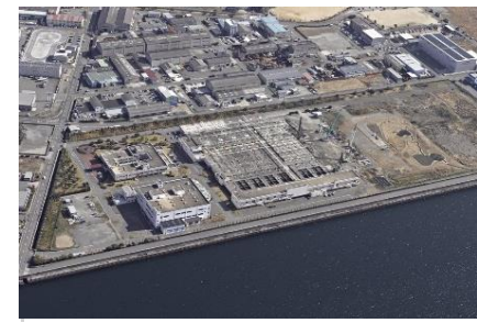
西下水処理場
