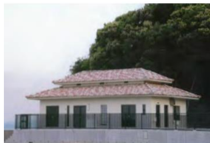
小口農業集落排水処理施設
