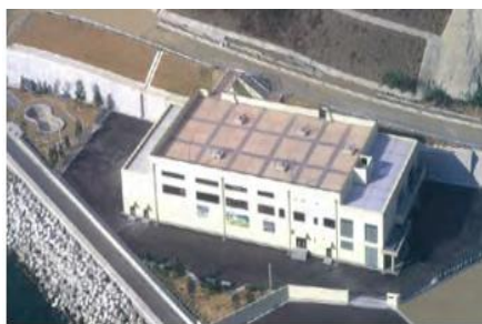
野母漁業集落排水処理施設
