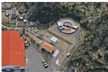
伊王島浄化センター
