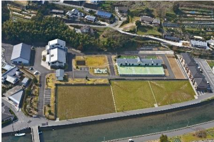
琴海南部浄化センター
