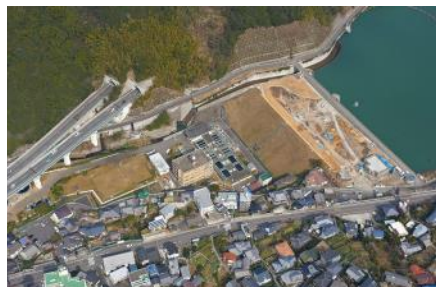
本河内浄水場
