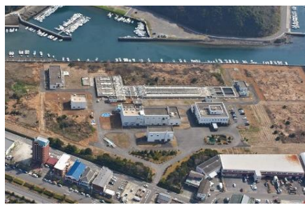
三重下水処理場
