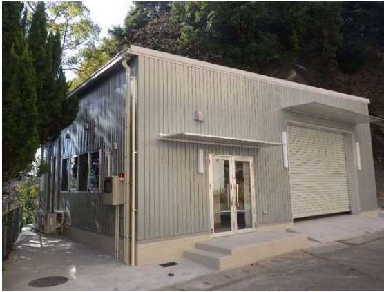
【旧西工場の煙突跡地に整備したストックヤード】 (R6.2 完成)
