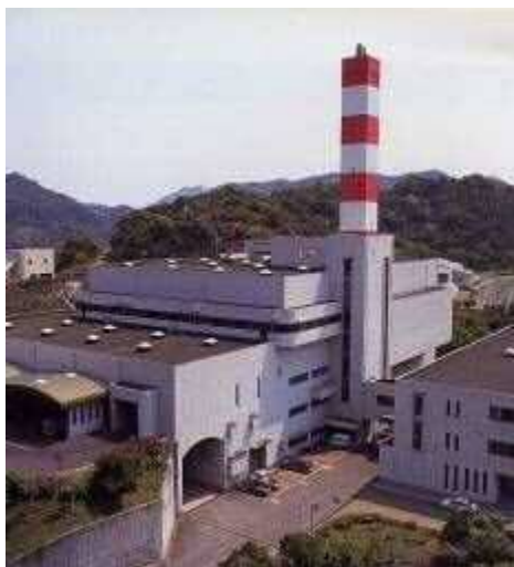
●東工場 所在地 長崎市戸石町 34-2 完成年月 昭和 63 年 3 月 処理能力 300t/24h
