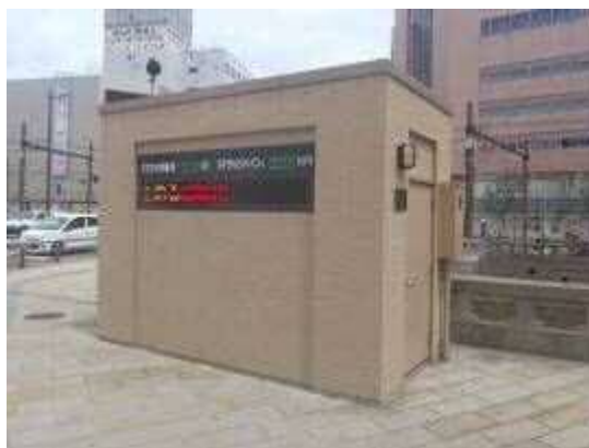
中央橋自動車公害測定局
