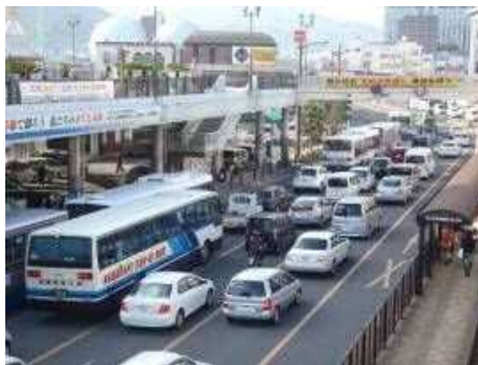
国道 202 号(長崎駅前)の状況
