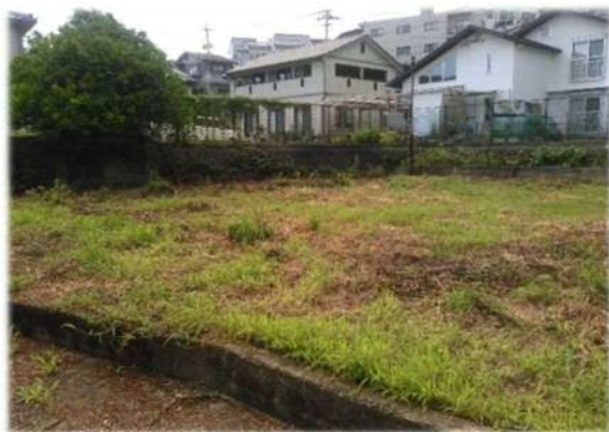
整備開始後（除草作業中）
