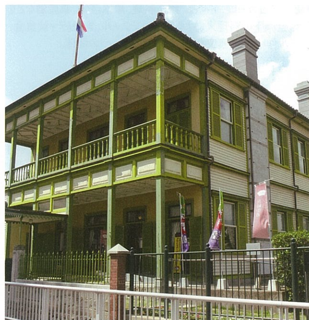
▲旧長崎内外倶楽部は歴史的建造物。レストランとして活用されている。
