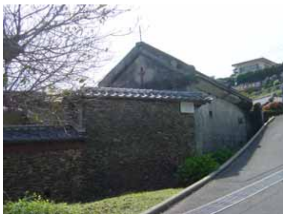
マカロニ工場と「ド・ロ壁」技法の石積塀
