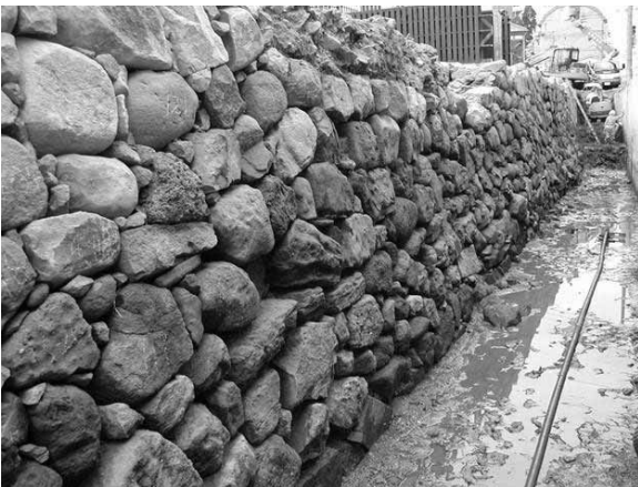
発掘された南側護岸石垣
