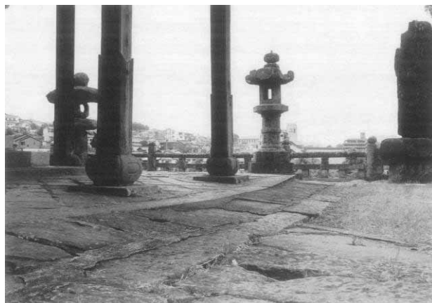
【局所的な地盤沈下】
