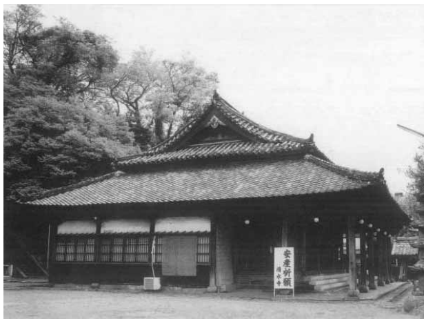
【保存修理着手前の本堂（北側面）】
