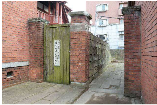
⑥-4 職員住宅北側仕切石塙
