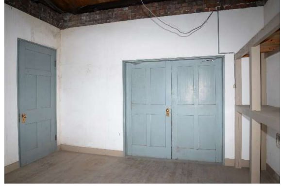
③-1 職員住宅・煉瓦棟 1階（給仕人室）
