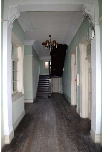
① 本館1階（ホール）
