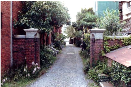
⑦ 本館東側仕切門
