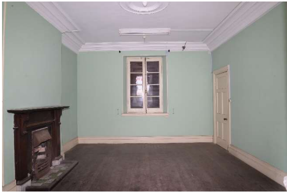
③-1 職員住宅・煉瓦棟 1階（居間）
