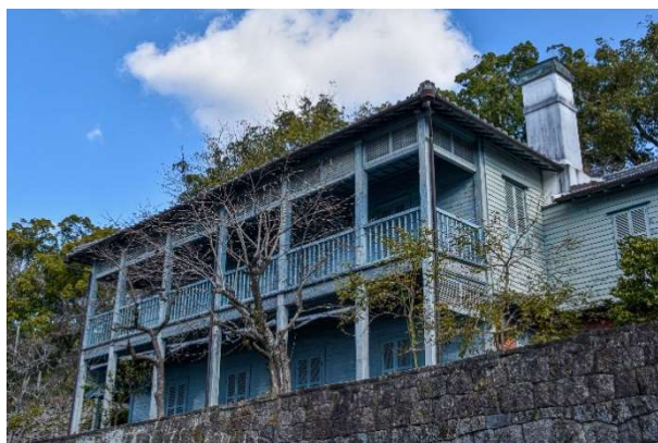
建物外観（近接する車道より）
