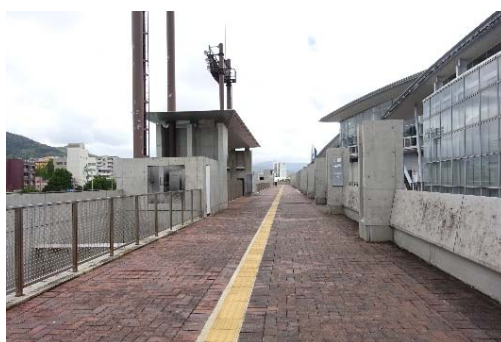
プロムナードは、コンクリートなどから構成されており、人工的な印象が強い。
