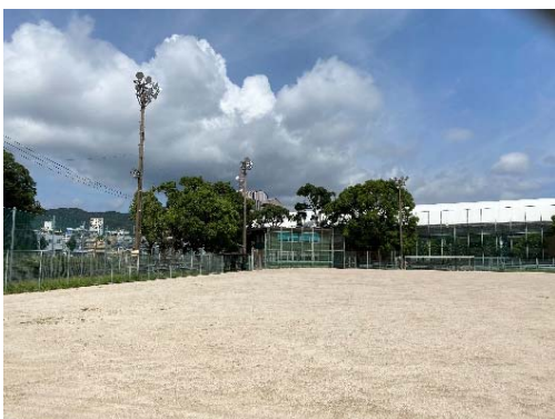
ソフトボール場 【照明設備、グラウンド】 昭和61年3月設置(改修) (令和2年度末現在35年経過)
