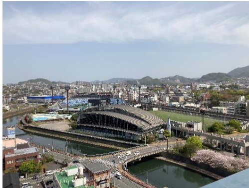
市民プール（屋内） 平成8年10月設置 (令和2年度末現在25年経過)
