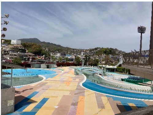
市民プール（屋外） 平成8年10月設置 (令和2年度末現在25年経過)
