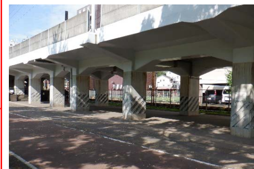
陸上競技場東側に位置するJR高架下空間が有効活用されていない。
