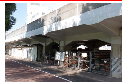
陸上競技場東側に位置するJR高架下空間が倉庫等として活用されている。
