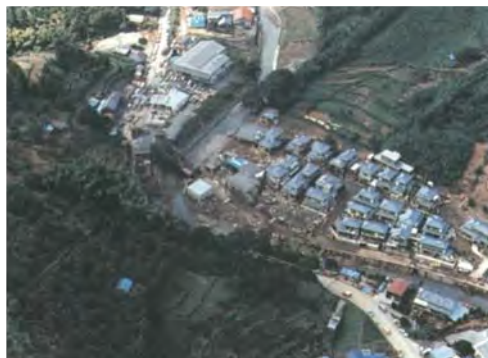
長崎大水害の被災状況 （長崎市茂木町付近）
