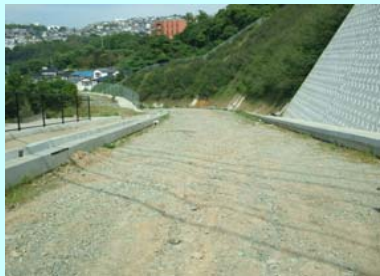
■道路事業 出雲17号線(施工中)
