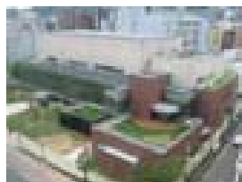
市立図書館の屋上緑化
