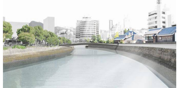
(玉江橋側より)
