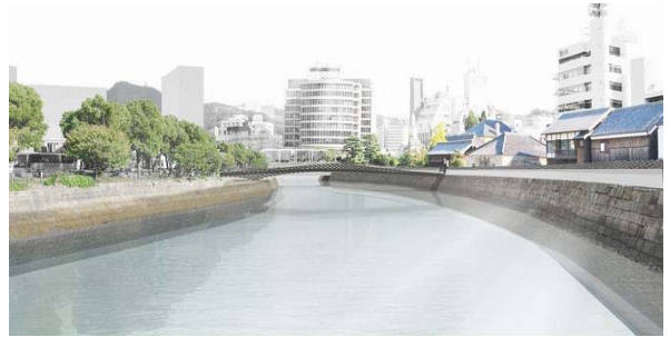
(玉江橋側より)
