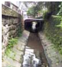
▲写真8 しとき川と三角溝
