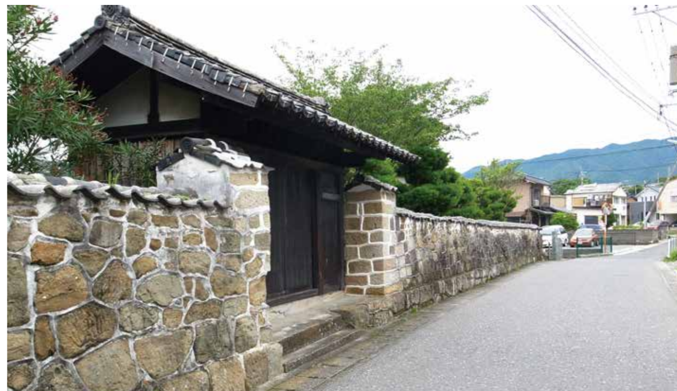
深掘で最大最長の石塀は野面積で漆喰で留めてある
