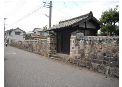
写真：樋口家表門及び石塀（深堀地区）
