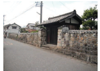
写真：樋口家表門及び石塀（深堀地区）
