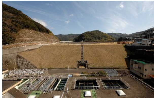
本河内高部水道施設（堰堤）
