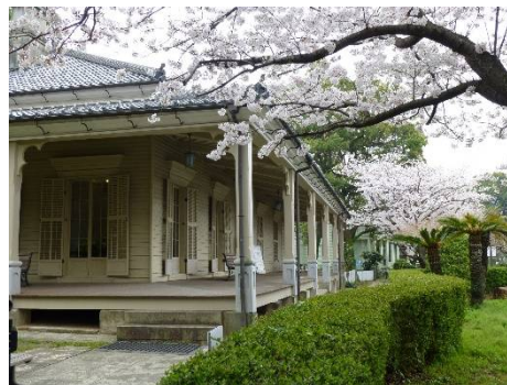
東山手地区内の木造洋風建築
