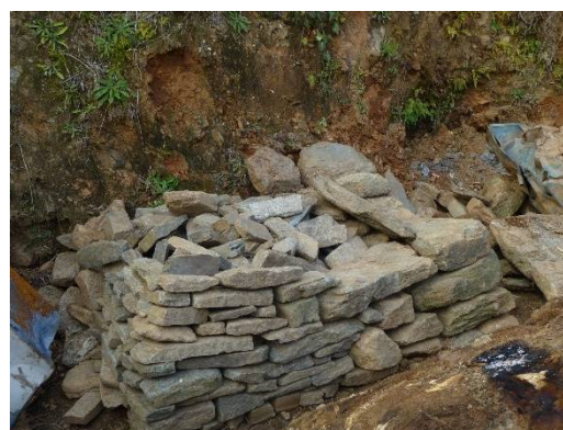
石積み用の石のストック
