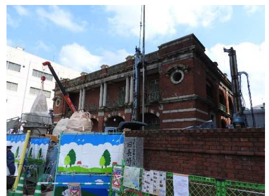
旧長崎英国領事館(重要文化財)の改修工事
