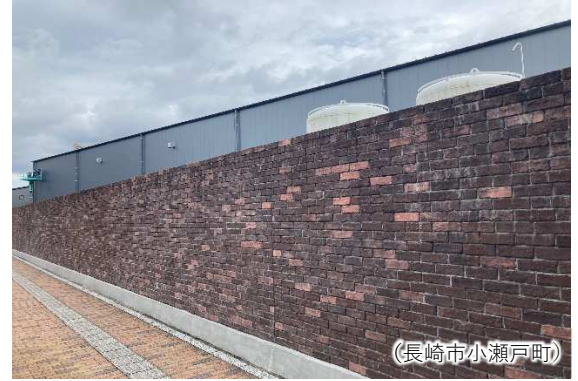
圧迫感のない塀で遮蔽している。
