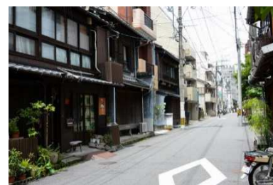
中島川・寺町地区の町家
