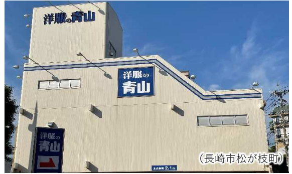
屋上広告物を設置せず、壁面広告のコーポレートカラーの字色と文字色を反転して使用している。(長崎市松が枝町)
