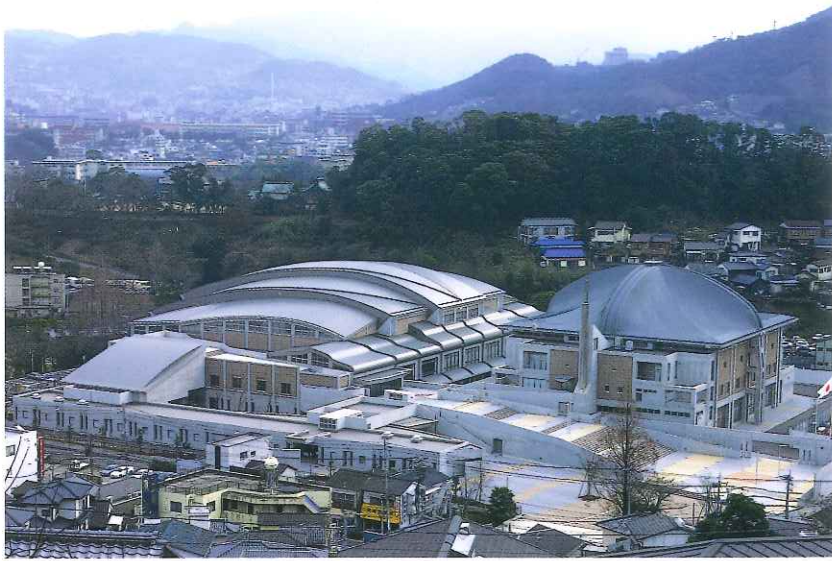
長崎県立総合体育館 所在地/長崎市油木町
