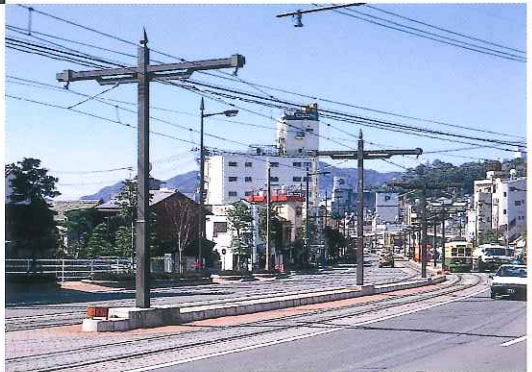
蛸茶屋から新大工までの 電車通り・電気軌道中央柱 所在地／一般国道34号日見バイパス建設事業 (馬町～蛸茶屋)
