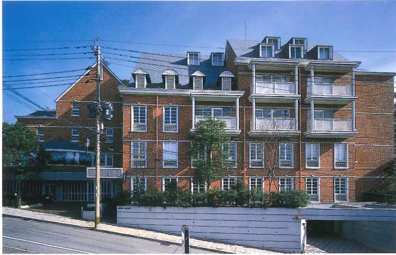
金子建設株式会社本社ビル 所在地／長崎市松山町
