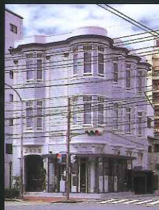
泉写真館 (川口町)
