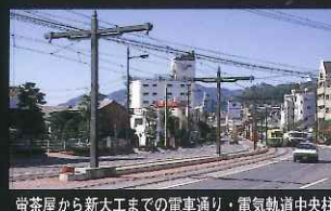
蛸茶屋から新大工までの電車通り・電気軌道中央柱
