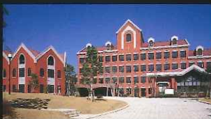
山里小学校 (橋口町)
