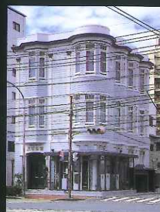
泉写真館 (川口町)
