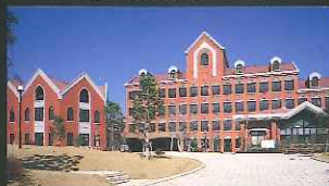
山里小学校 (橋口町)
