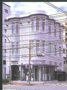
泉写真館 (川口町)
