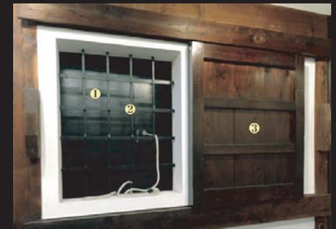
<2층> 외미닫이문 ①철재로 된 외미닫이문 ②철제 격자문 ③외미닫이 판자문
