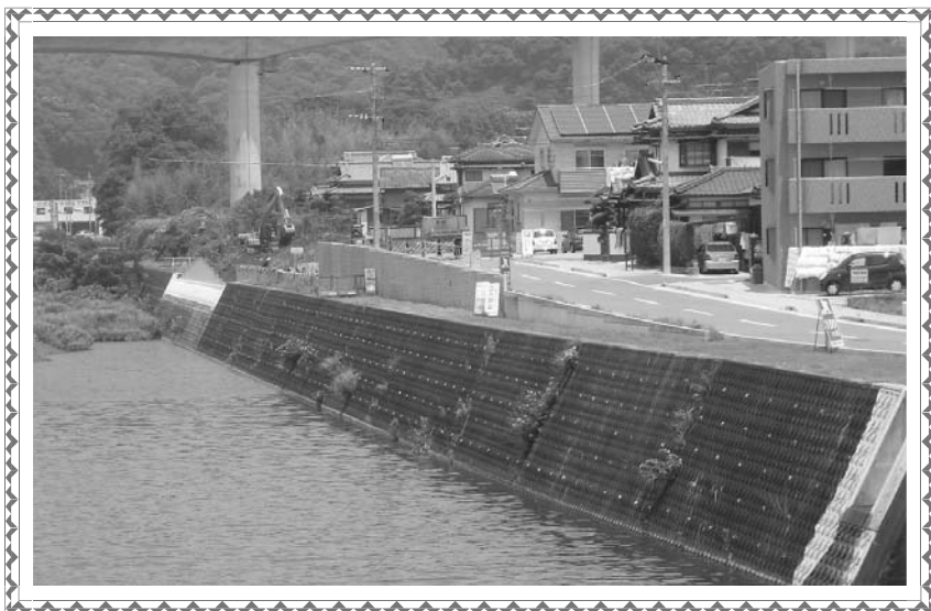
工事中の都市計画道路八郎川東川端線
