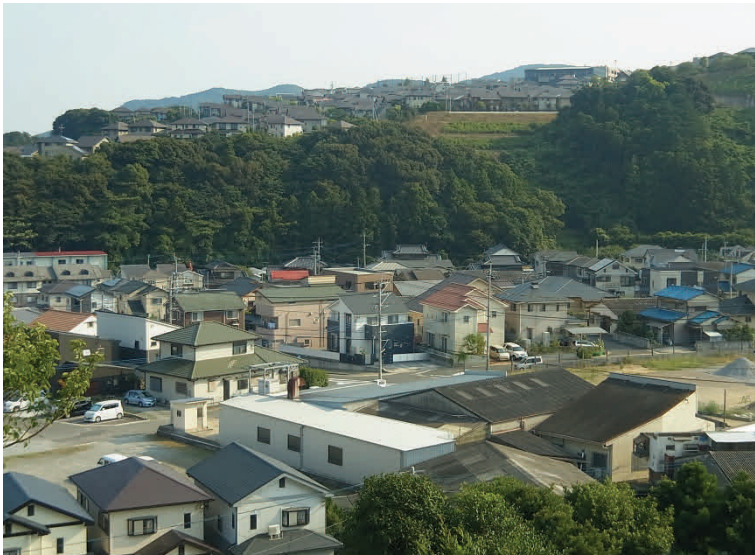
※ 造成後の平間町の街並み(古河、北地区)
